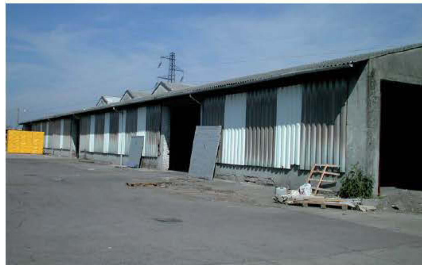
Magazzino edile prima dell'intervento.
