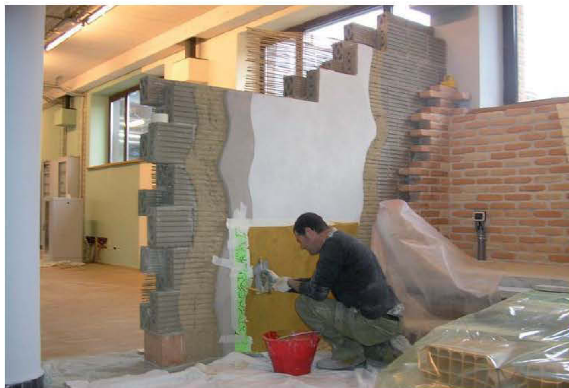
Realizzazione di una parete in argilla cruda a scopo espositivo.
