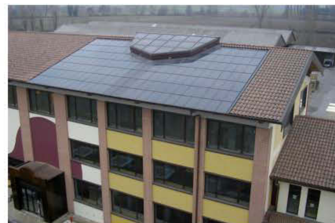
Vista del tetto con lucernario integrato fotovoltaico.
